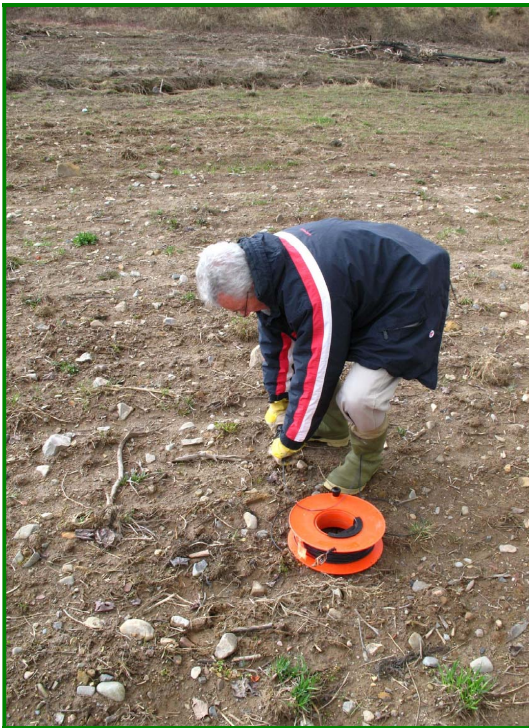
Installation d'une mise à la terre au moyen d'une tige métallique
